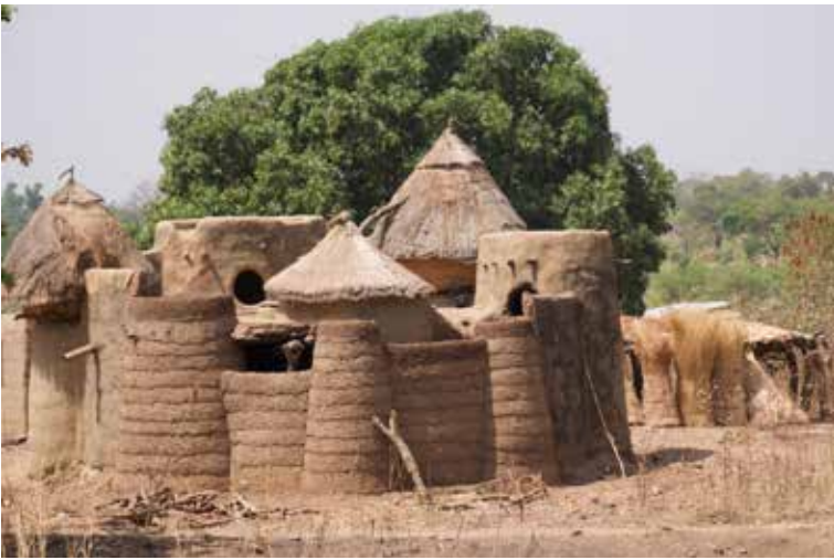
✱ Tanken bak «tata somba»-hus, at frittstående kjegleformer har en avkjøl-ende effekt, inspirerer dagens arkitektur i Vest-Afrika. Bildet er fra Benin.
